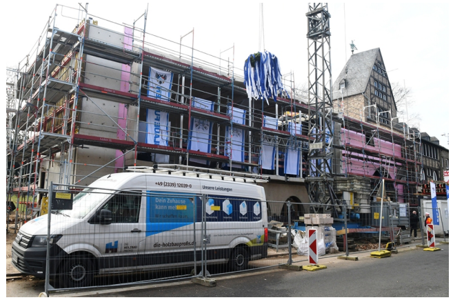
Auch von außen ein imposanter Anblick: der große Saal öffnet sich stadtseitig mit deckenhohen Fenstern
