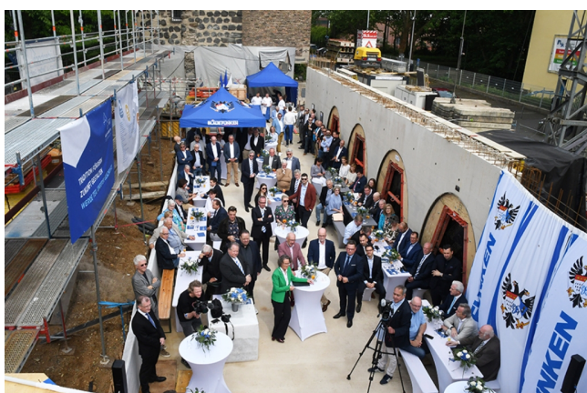
Der Entlastungsbau wächst in die Höhe: die ersten architektonischen Details sind für die Gäste des ersten Turmfestes
